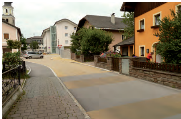
Zonenbalken in der Begegnungszone in Thalgau. Hierbei handelt es sich um einen gelblichen Splitt-Mastix Belag
