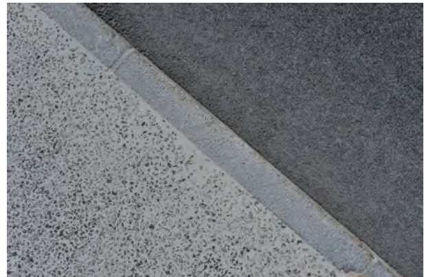
Confaltfläche bei der Universität Salzburg im Nonntal
